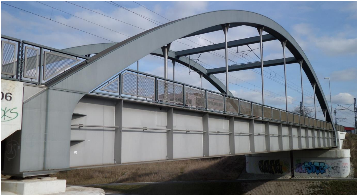
Obr. 7 - Ukázka obloukového ocelového nosníku
