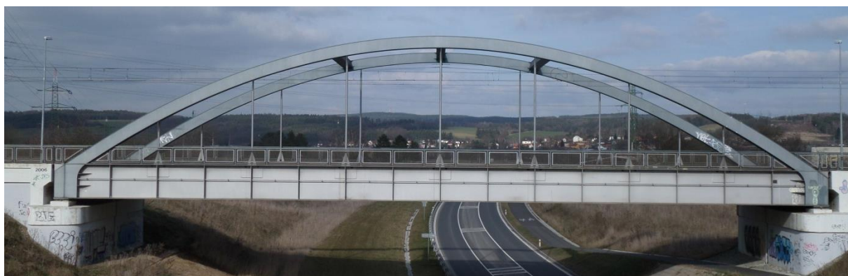
Obr. 3 - Obloukový nosník tvaru konkávní řetězovky (pohled 2)
