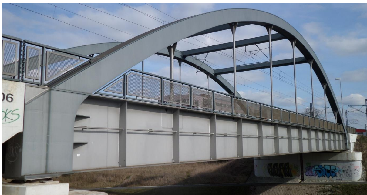
Obr. 2 - Obloukový nosník tvaru konkávní řetězovky (pohled 1)
